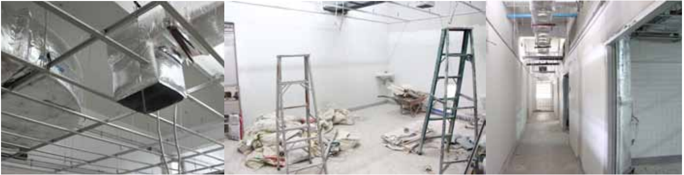
ปรับปรุงอาคาร 3 ชั้นล่าง ให้เป็นระบบ HVAC เพื่อเลี้ยงกระต่าย
